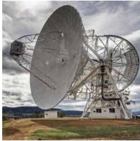
Apparecchiature di telecomunicazione e sistemi di controllo.
