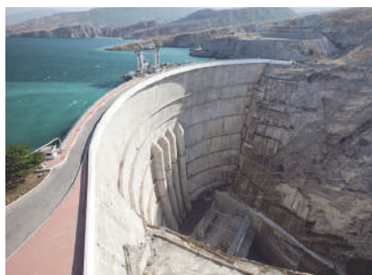
Impianti energetici Energy plants
